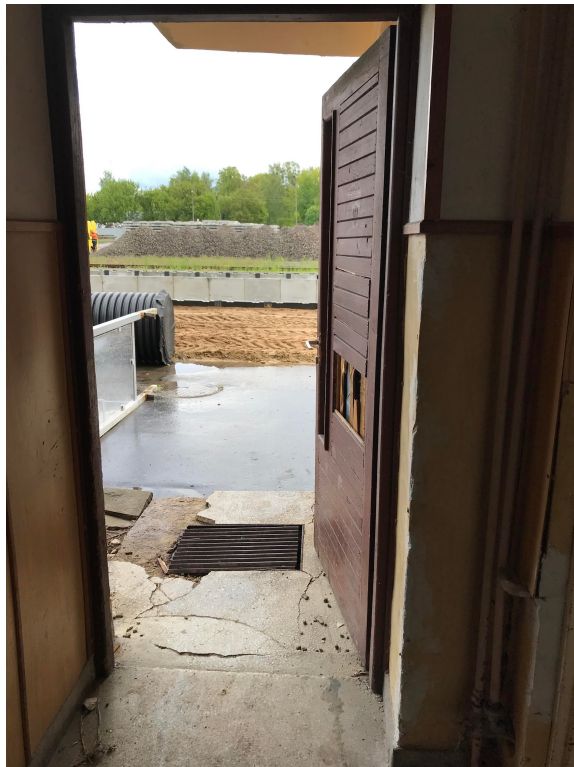
Fot. 3 (po lewej). Wejście do strefy biurowej ze stopniem i zniszczoną posadzką. Fot. 4 (po prawej). Klatka schodowa w części administracyjnej.
