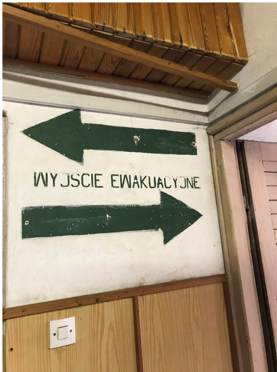
Fot. 5 (po lewej). Nieaktualne oznaczenie wyjść ewakuacyjnych.
